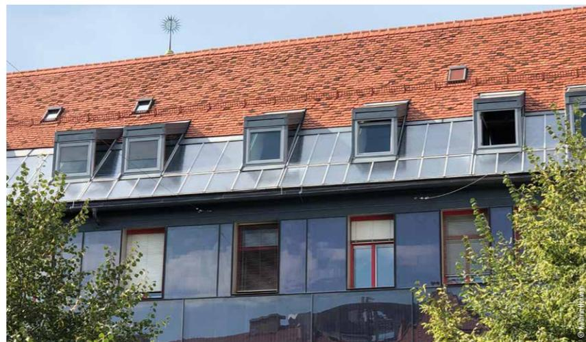
Am Franziskanerkloster in Graz wurden an der Fassade Photovoltaik und am Dach Thermosolaranlagen integriert.
